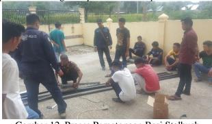
Gambar 12. Proses Pemotongan Besi Stalbush
